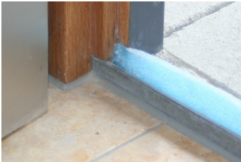
Bild 1 Stahlwinkel als unterer Anschlag einer Haustüre
